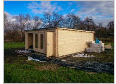
Neubau des Naturerlebnispavillons auf dem AuenLand
