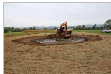
Baggerarbeiten für einen neuen Tümpel
