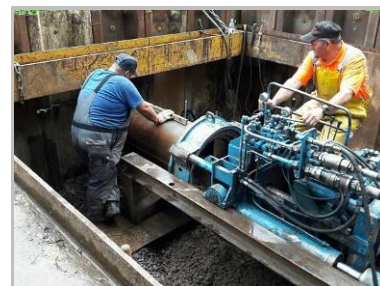
Im Rohrpressverfahren ein Rohr unter der Straße durchgeschoben
