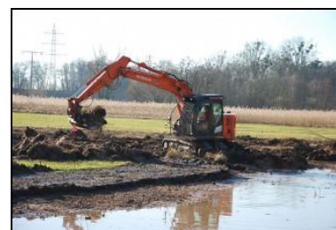
Baggerarbeiten für einen neuen Tümpel
